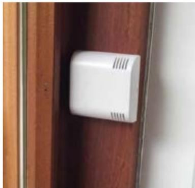
Afin d'assurer un suivi efficace et précis des consignes de températures dans tous les bâtiments communaux, pas moins de 170 sondes de suivi en temps réel de la température ont été déployées dans le courant des mois de septembre et d'octobre. Ces sondes permettront de s'assurer que les obligations contractuelles sont respectées par l'exploitant des chaufferies.
