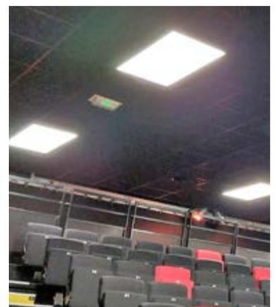
La salle Maupassant a bénéficié d'un remplacement des luminaires « néons » par des panneaux leds « néons » par des panneaux leds au nombre de 15 panneaux leds de dimensions 1200mm x 600mm. Les travaux ont été réalisés par l'entreprise Sfee pour un montant de 11 185,20€ TTC.
