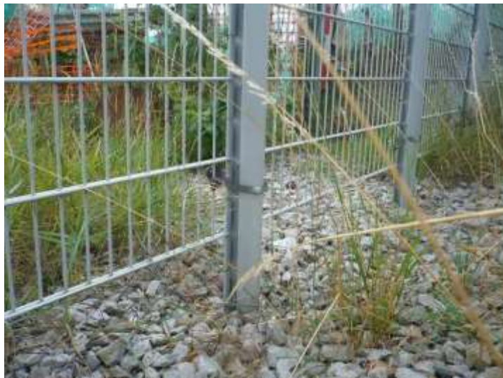
Figure 65 : Exemple de clôture perméable à la petite faune
