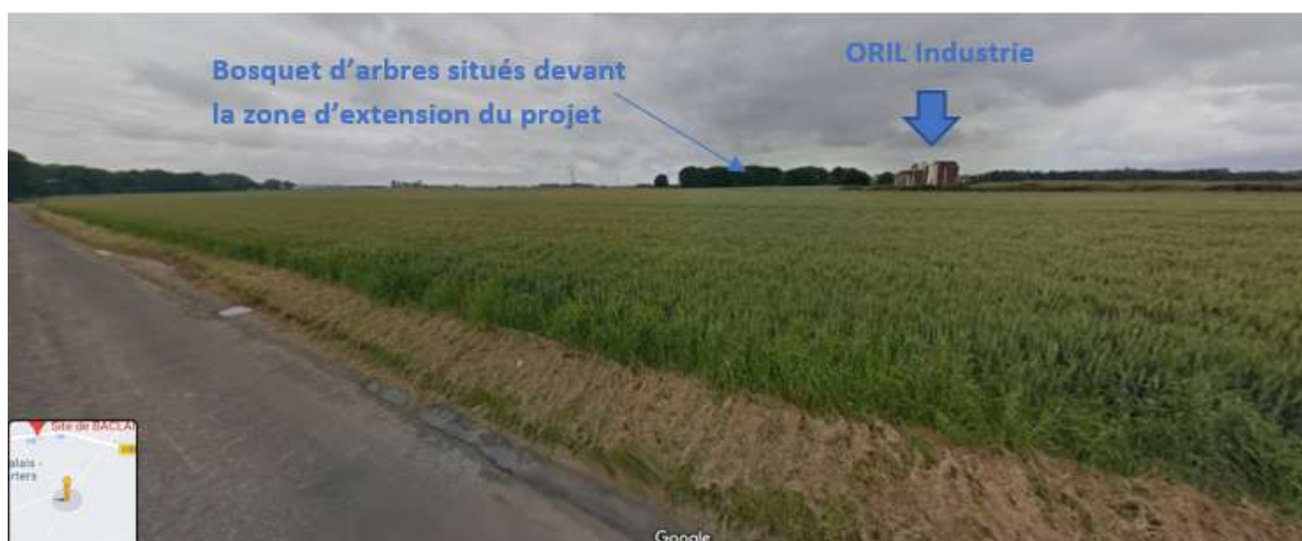
Figure 45 : Vue (1) sur les futures installations du projet depuis la route de Bolbec (Crédit : Google Street)
